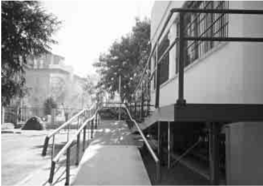
Pasarela acceso entrada edificios para Personas con dificultad de deambulaci3n.
