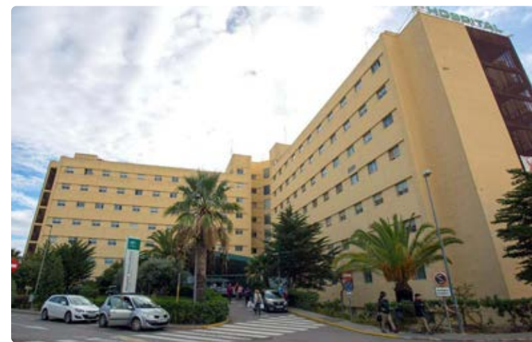
Hospital Torrecárdenas de Almería
